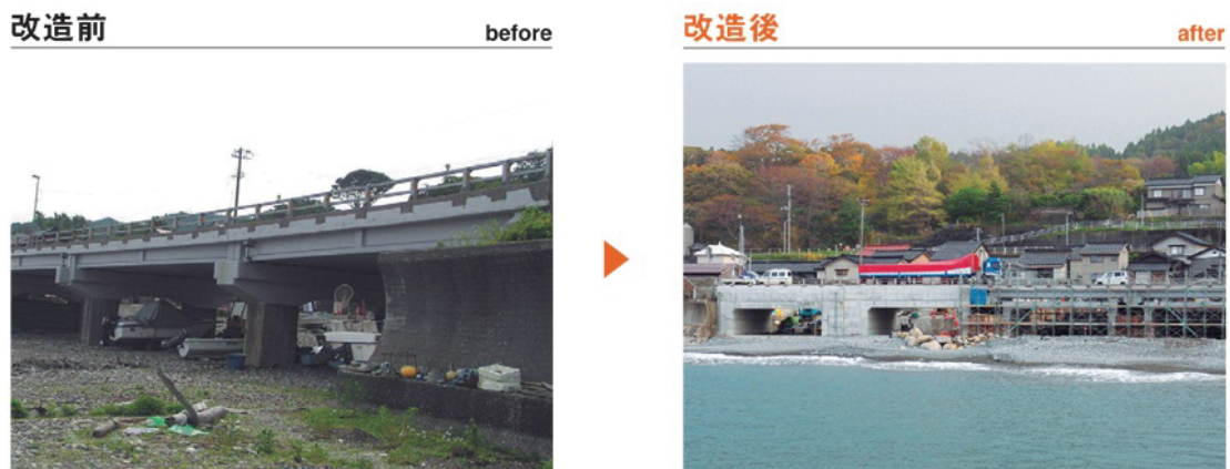
図 1-1 新潟県の橋梁（両鬼橋）における掛替の事例 15)
