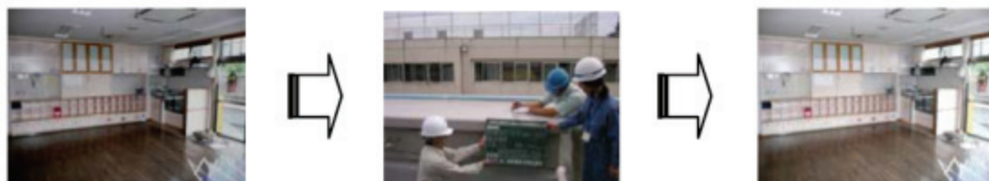
図 2-5 部位改修の様子 14)
